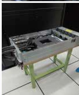
冷却ユニット (冷却能力 200 kW/unit)
