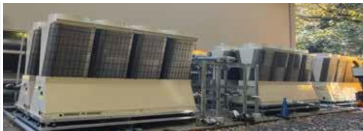
冷却ユニット (冷却能力 200 kW/unit)
